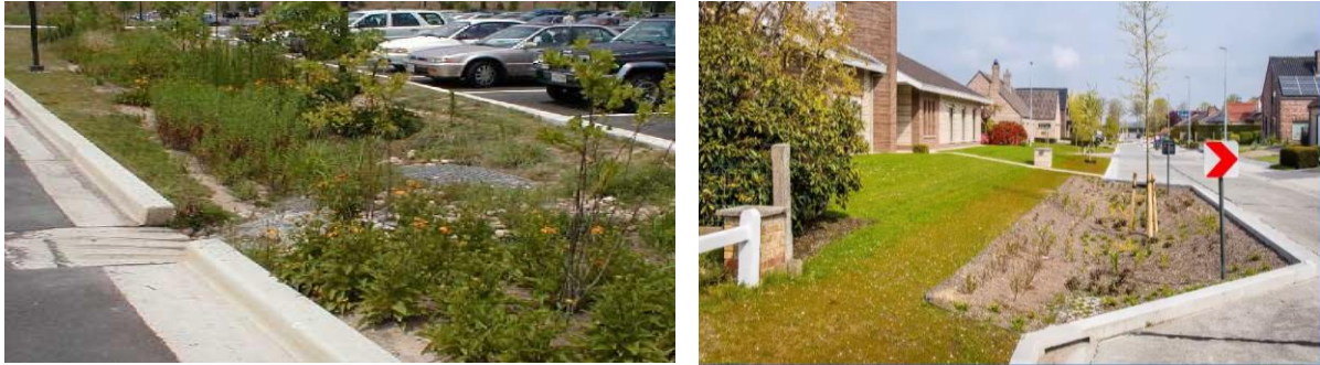
Figuur 28: Voorbeelden van gat in boordsteen (links onder) en verlaagde wegversmalling (rechts onder). Bron: Aquafin
