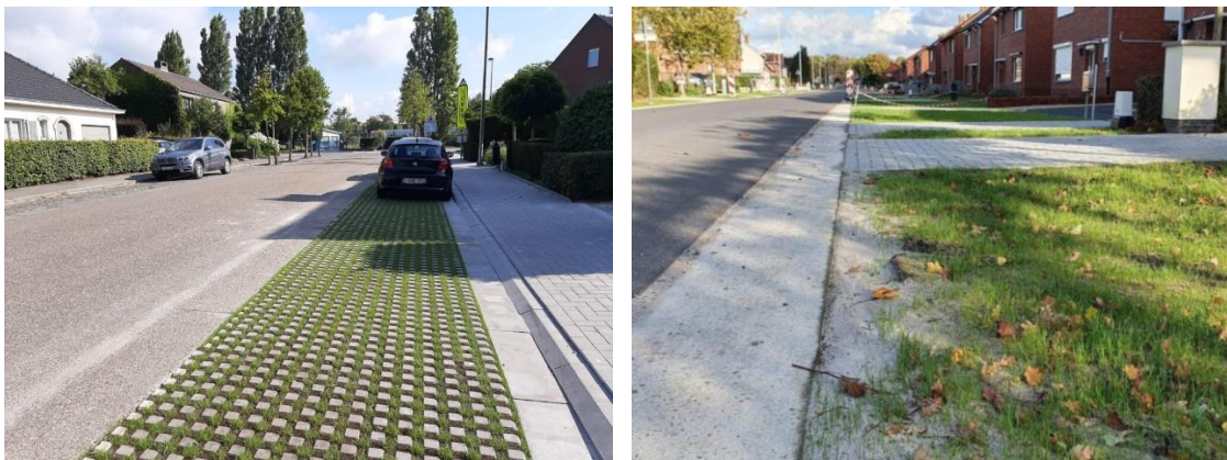
Figuur 25. Voorbeelden van parkeerplaatsen met waterdoorlatende verharding in Temse (links) en ontharde berm in Beringen (rechts). (Bron: blauwgroenvlaanderen.be)
