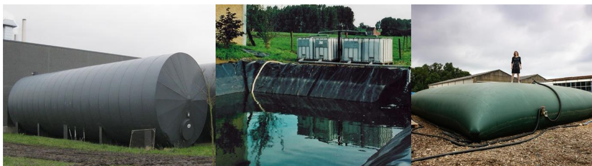
Figuur 44. Buffertanks, een foliebekken en een zak, voor de opslag van regenwater (Bron: Departement Landbouw en Visserij; Provincie Oost-Vlaanderen; De Standaard).
